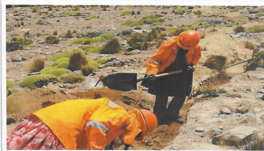
Trabajo topográfico para la construcción de zanjas de infiltración
