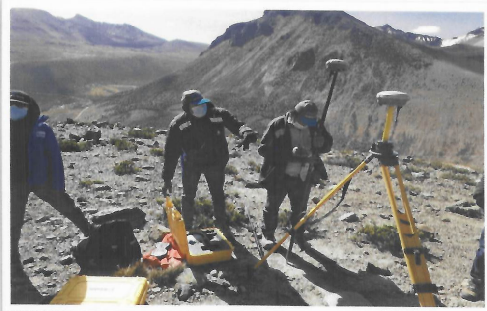
Trabajo topográfico para la construcción de zanjas de infiltración
