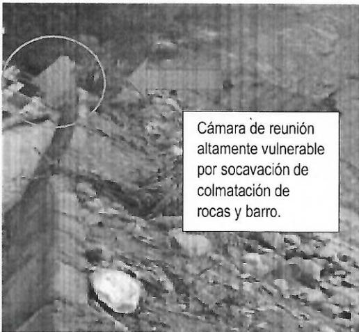
Cámara de reunión altamente vulnerable por socavación de colmatación de rocas y barro.
