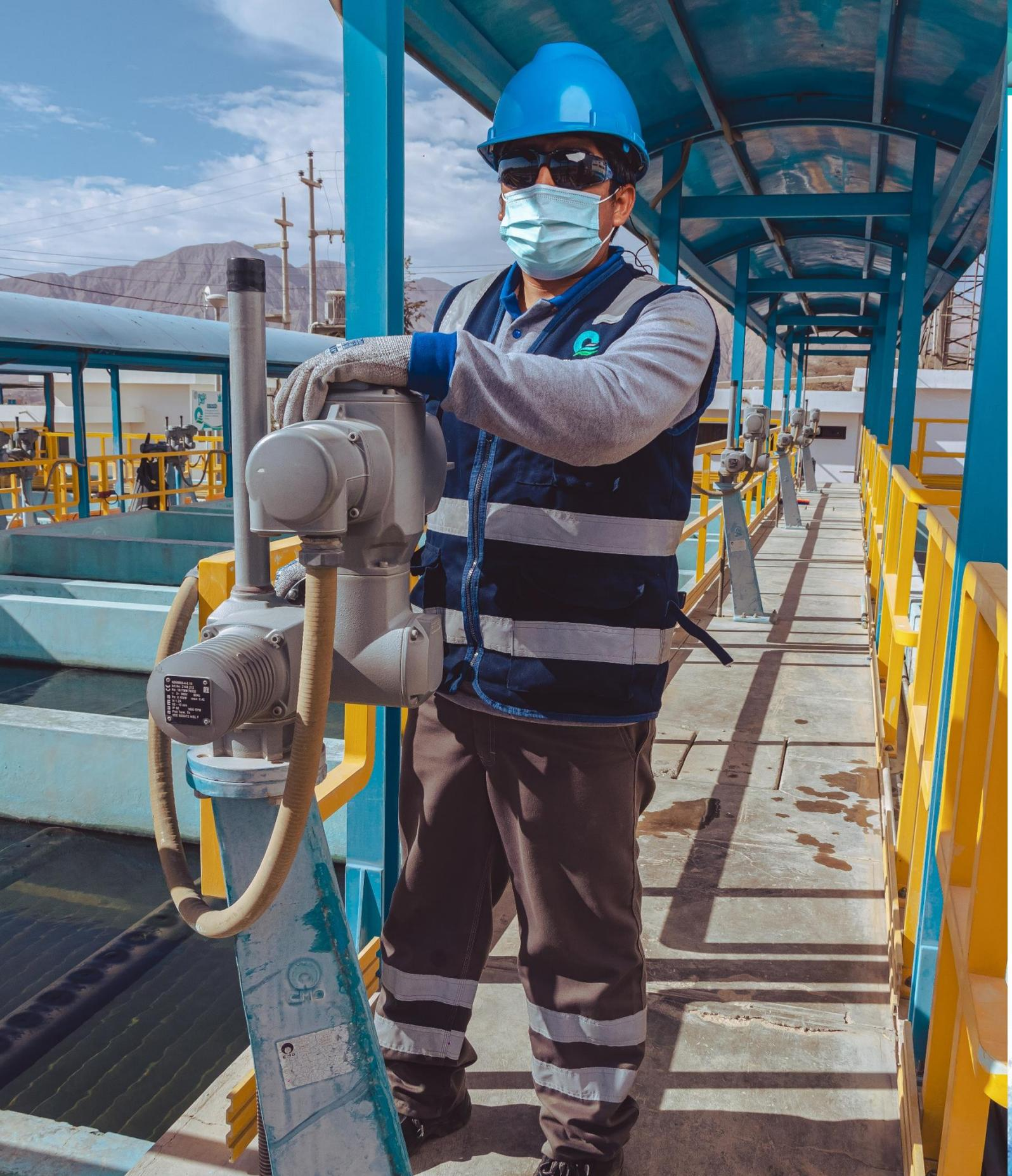
Operación de válvulas compuerta mecanizadas en la unidad de tratamiento PTAP Chen Chen.
